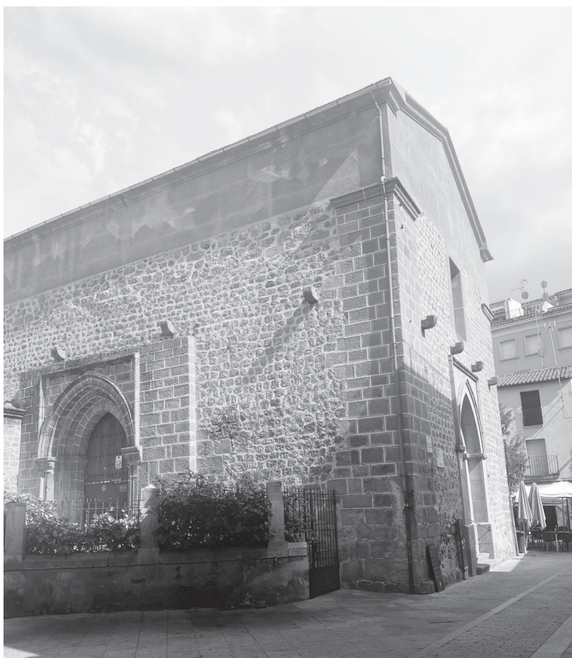
Fig.9. San Esteban con paramentos recrecidos por encima de las ménsulas.
