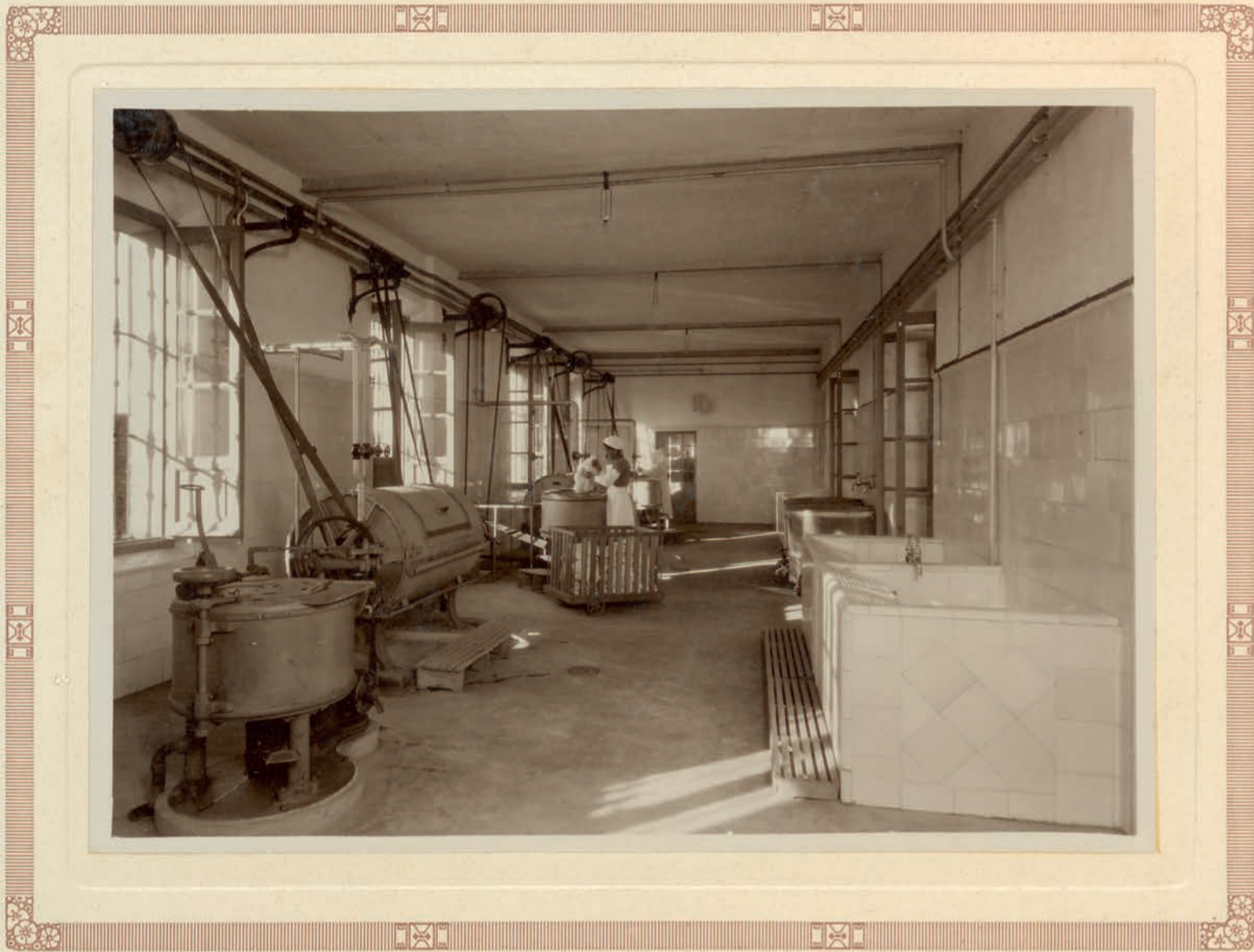
Hospital de Cáceres. = Lavadero.
