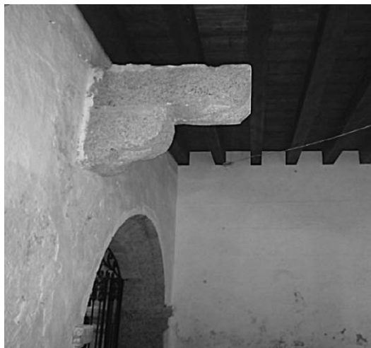
Foto n.º 14. Matacán en el interior de la Iglesia de Aldea del Cano.
