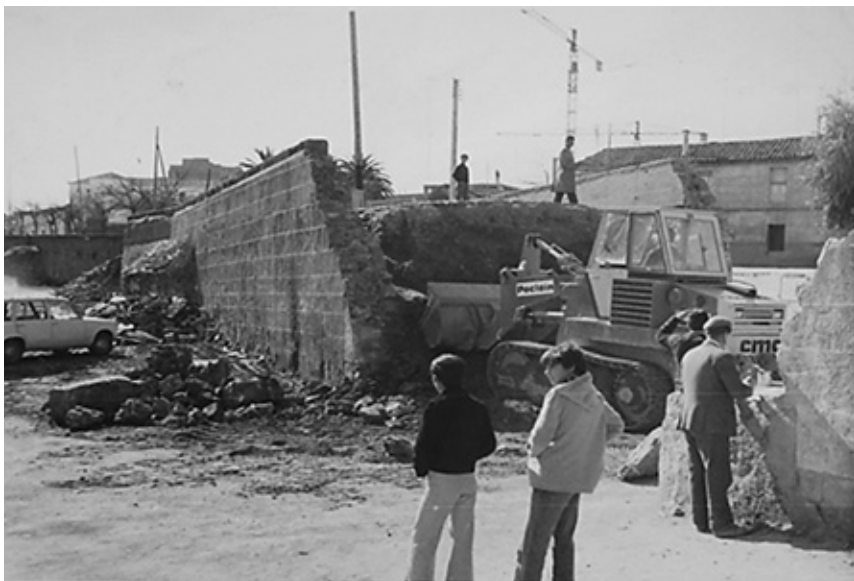
Figura 10: Obras en el Puente de San Francisco, años 70 (siglo XX)
