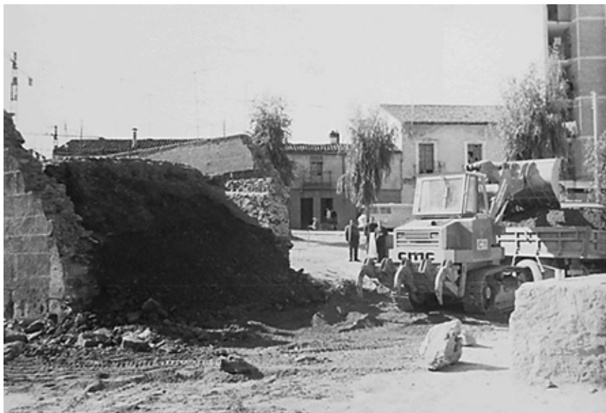
Figura 8: Derribo y remodelación del Puente de San Francisco, años 70 (siglo XX)
