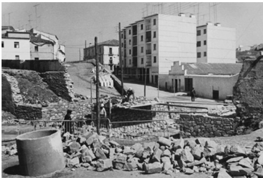
Figura 9: Remodelación del Puente de San Francisco, años 70 (siglo XX)
