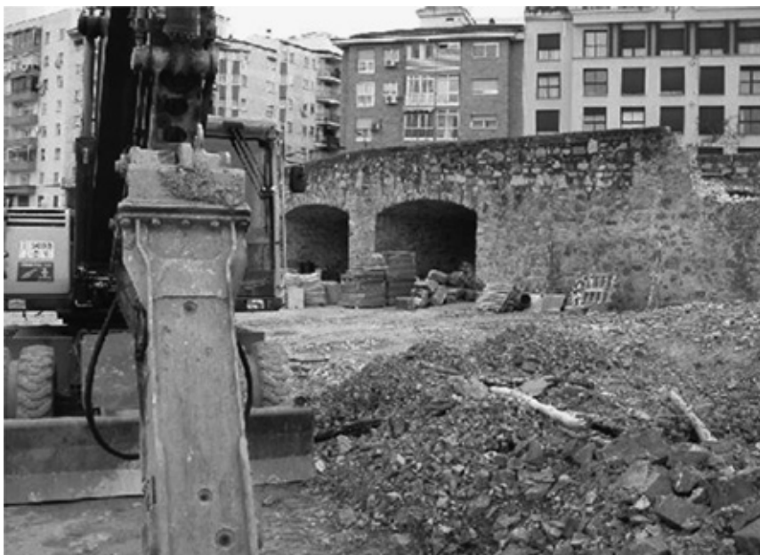
Figura 11: Obras en el Puente de San Francisco (2005)
