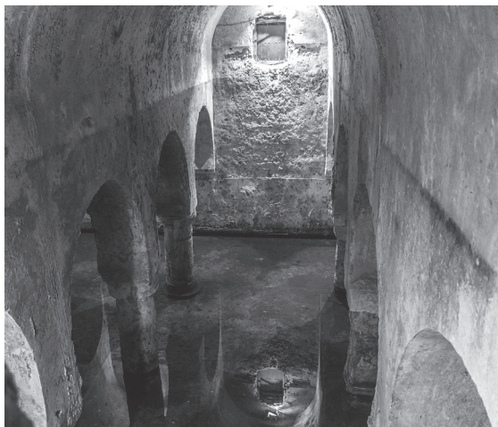
Fig. 3. Una de las naves del aljibe con cubierta de bóveda de cañón que asienta sobre las arquerías. En el muro del fondo, y reflejada en el agua, una ventana del interior de la Casa de las Veletas que comunica con la cisterna.
