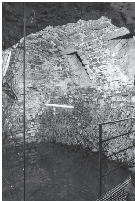
Fig. 6. Interior de la cisterna de la calle San Roque.
