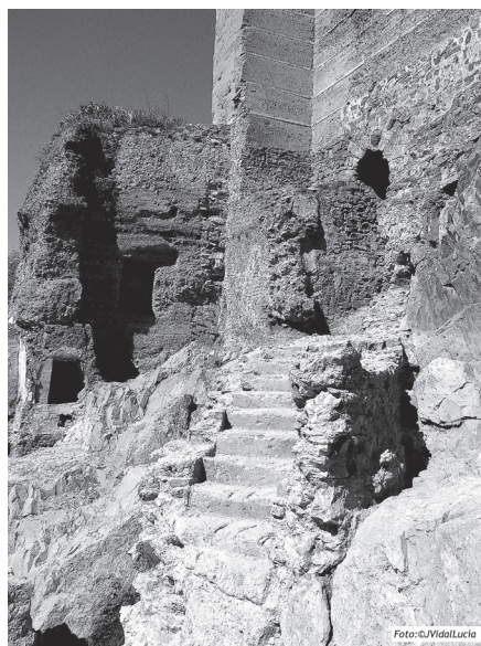
Fig. 9. Vista de la escalera de acceso a los brocales en el momento de la restauración en 2005.
