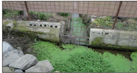
**Foto 11.** Salida de Cagancha a la altura del matadero municipal. Apenas un metro de anchura para la evacuación.
