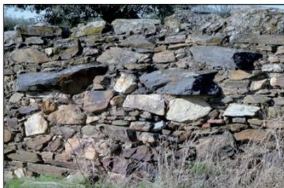
**Foto 3.** Pared de cercado en las inmediaciones de la Charca Nueva. Se observan las tres clases de rocas del subsuelo: granito, pizarra y corneana o pizarra macho (color negro brillante).
