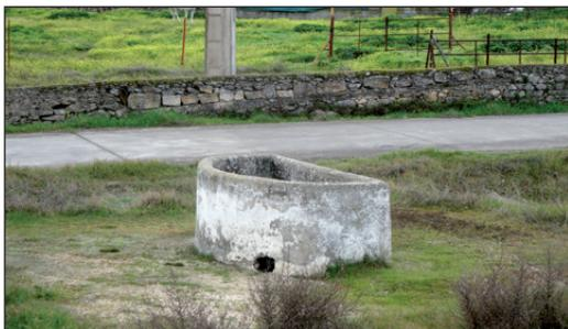
**Foto 13.** Pozo de las Cadenas, dotado de galerías suplementarias para aumentar su capacidad. Se utilizó para cebar el primer depósito.
