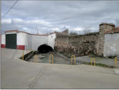
**Foto 9.** Rídículo margen de un escaso metro de ancho que causará problemas seguros cuando un temporal de lluvias desborde el arroyo.
