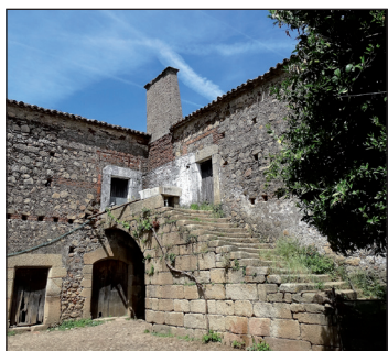
Figura 6. Interior del edificio principal del Asiento de Topete en la actualidad. Fuente: Archivo fotográfico de José Pastor Villegas, fotografía autorizada y realizada por el autor el 15 de abril de 2017.
