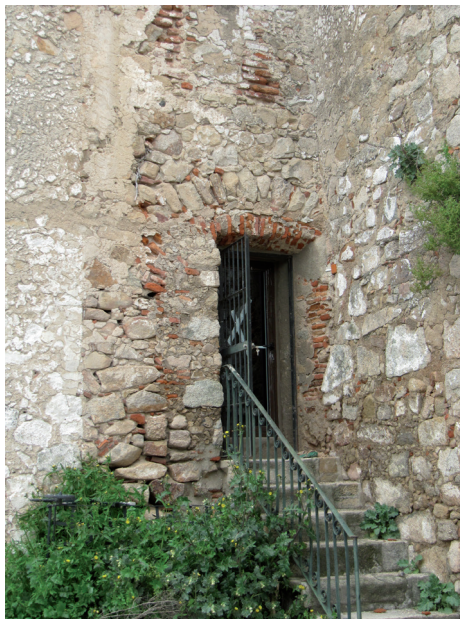
4.- Puerta de acceso a la torre
