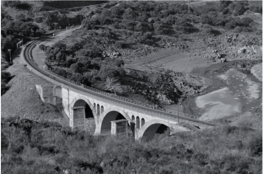
Fig.4. Puente de hormigón del ferrocarril sobre el arroyo Villoluengo. Se aprecian las pilas del primitivo puente metálico, de Eiffel, desmantelado hacia 1930.
