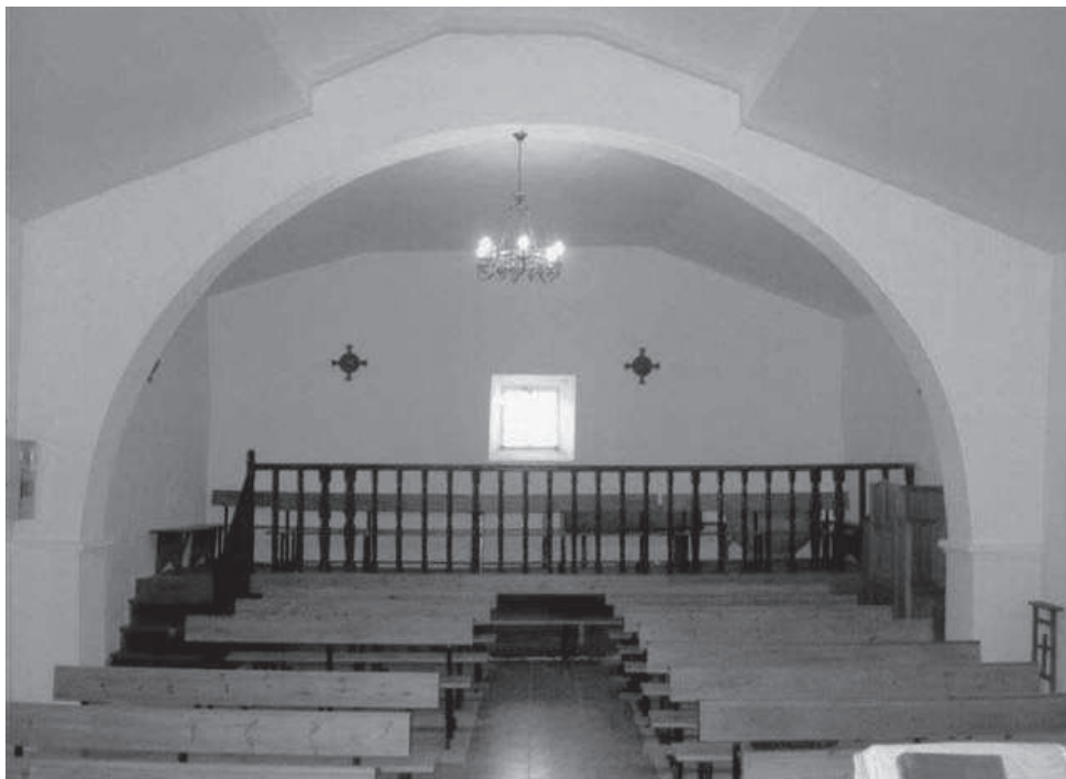
Reconstrucción de la cimbra de la parroquia de Valdelageve
