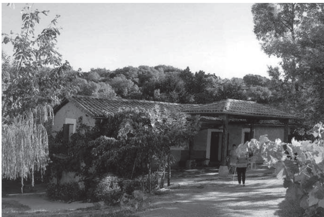
Casa en la que intervino Félix Monforte Chorro, junto al «Soteño» Vicentín. La parte delantera está rehabilitada.
