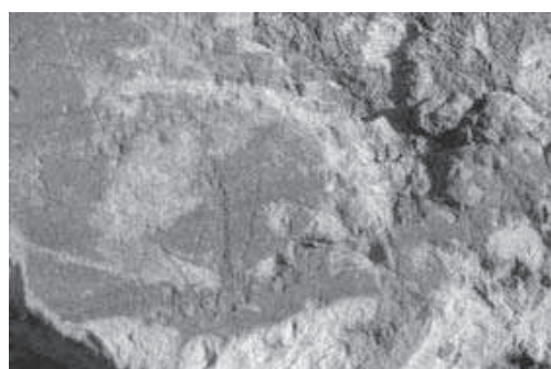
Foto 12.- Herradura deteriorada (Matababras)
