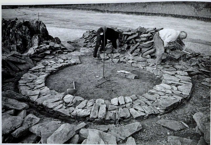
Foto 5. Primeras hileras de piedras.
