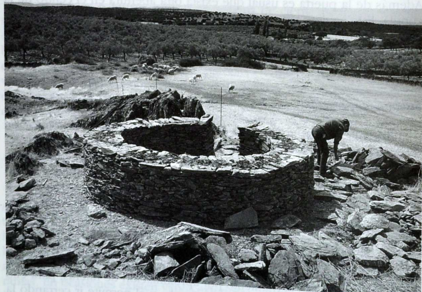
Foto 6. Inicio de la convergencia de los paramentos.
