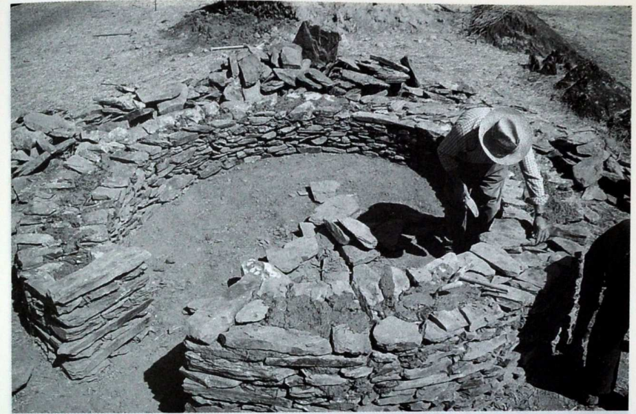
Foto 4. Manejo y precisión en las hileras del anillo circular.
