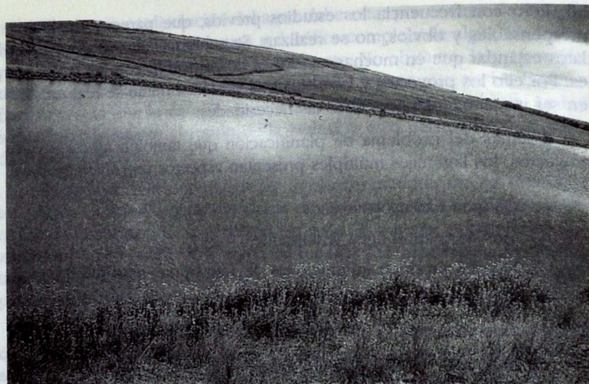
FIGURA 4.—Laguna facultativa con 9.000 m 2 de extensión perteneciente a la depuradora de Casar de Cáceres (Cáceres)
