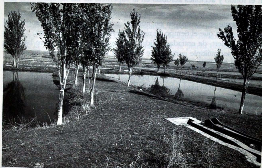
FIGURA 3.—Lagunas anaerobias en paralelo. Sierra de Fuentes (Cáceres)
