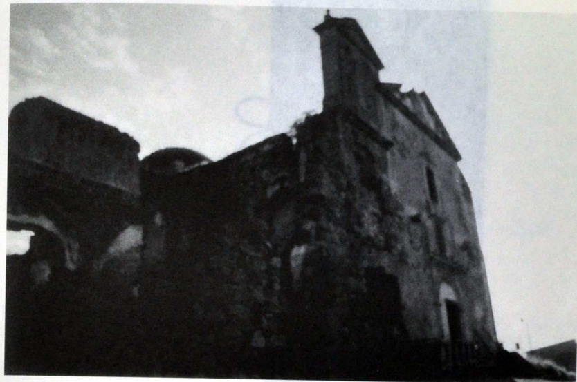
Fachada principal del templo y parte del convento, hoy totalmente destruido.
