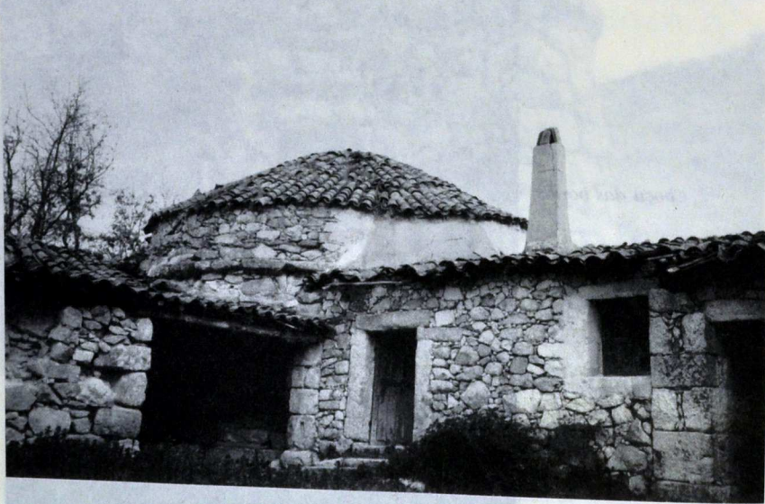
Chafurdón d'ojesto, típica casa de campo
