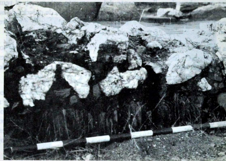
LÁM. I, 2: Villa. Muro sobre afloramiento de pizarra.
