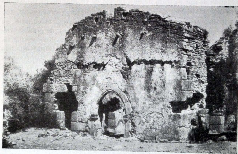
Fachada oeste y muro sur
